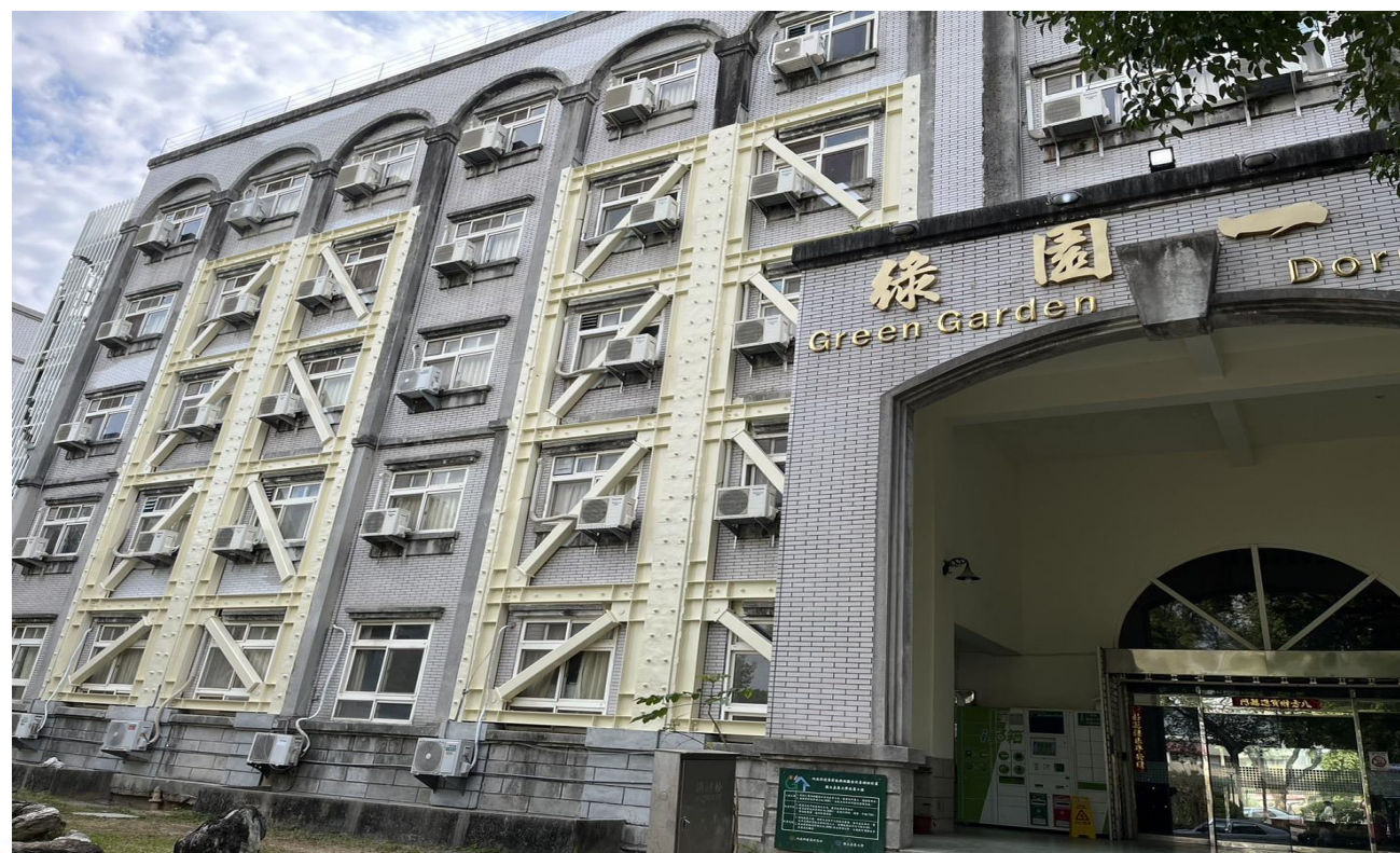
說明：民雄綠園一舍耐震工程完工正面
