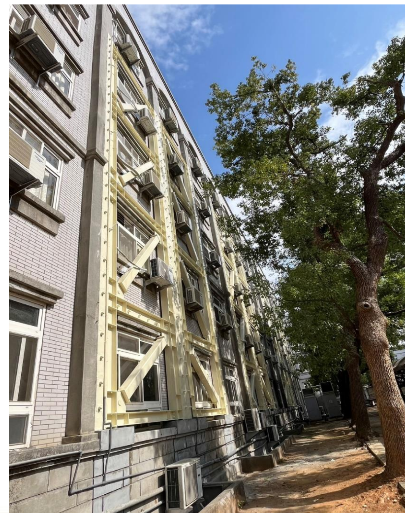
說明：民雄綠園一舍耐震工程完工後方
