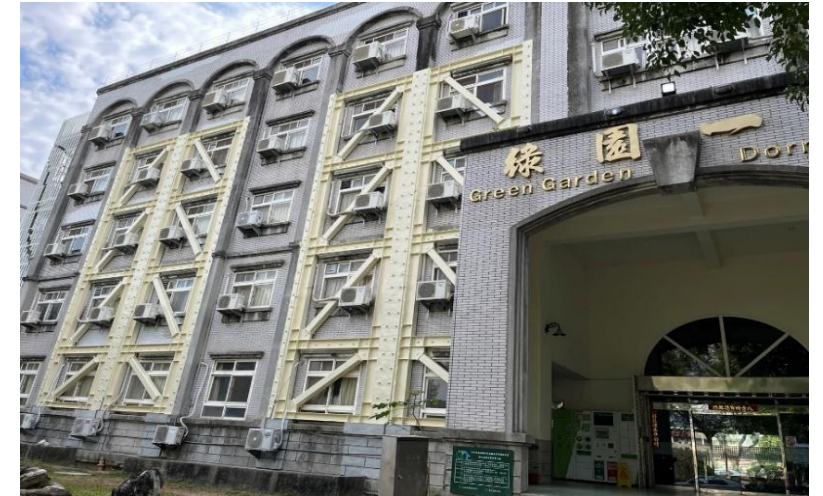
民雄綠園一舍耐震補強工程受益385床 (已於113年12月完工)
