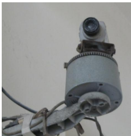
圖 3 安裝監視系統
