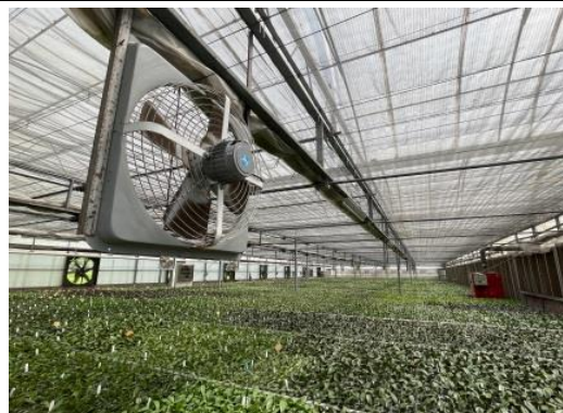
園藝技藝中心溫室內不安全廢棄小型風扇拆除
