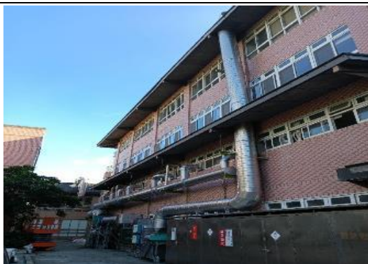
活動中心油煙處理及排放設施改善
