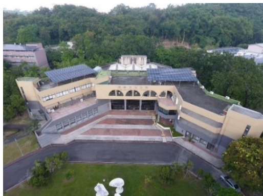
蘭潭校區太陽光電發電設備設置情形
