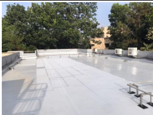
動物科學館等 2 棟建物頂樓滲漏防水工程
