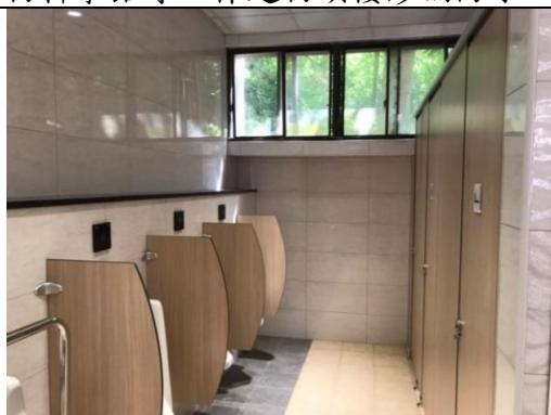
動物科學館及電物一館無障礙廁所改善工程
