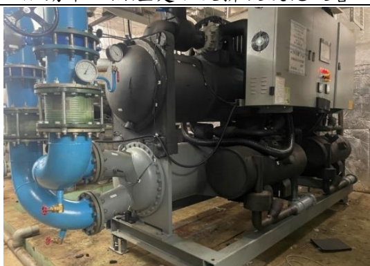
蘭潭校區圖書館太陽能冰水主機與智慧能源管理系統之建置
