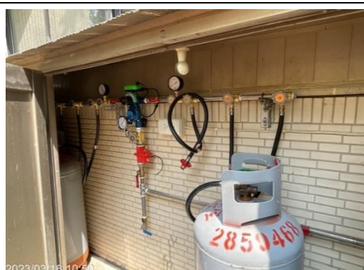
食品加工廠更換漏氣瓦斯管路，並加裝洩漏偵測器
