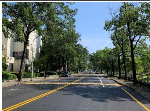
蘭潭校區 111 年度道路整修工程
