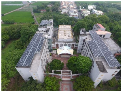
民雄校區太陽光電發電設備設置情形
