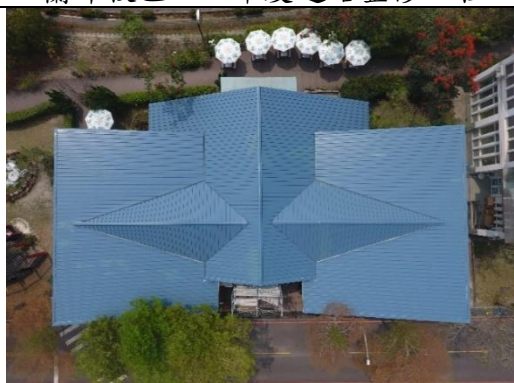
農產品展售中心(咖啡學園)屋頂汰換工程
