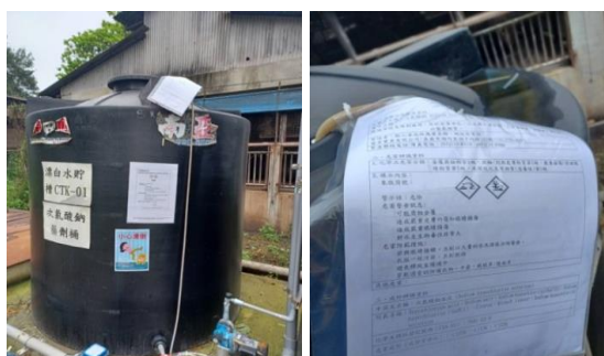
改善-漂白水已貼附危害標示及懸掛安全資料表
