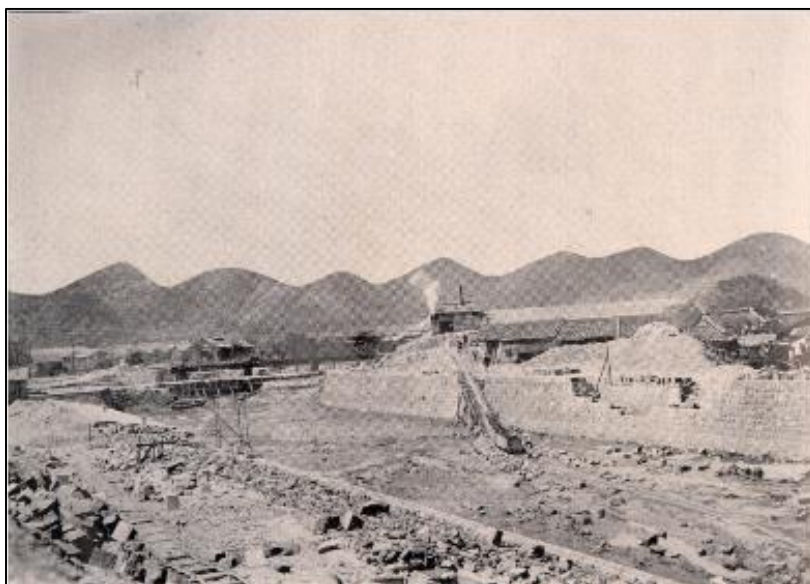
圖 5 蚵殼港溪上游水路改道工程
