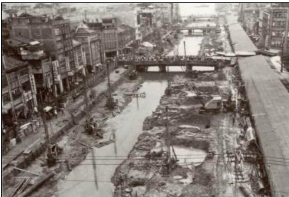
圖 17 正在興建加蓋工程的旭川河
