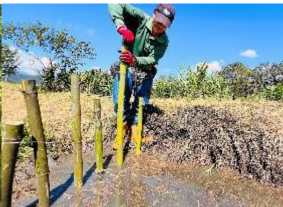
圖 17 架設攔水土堤結構
