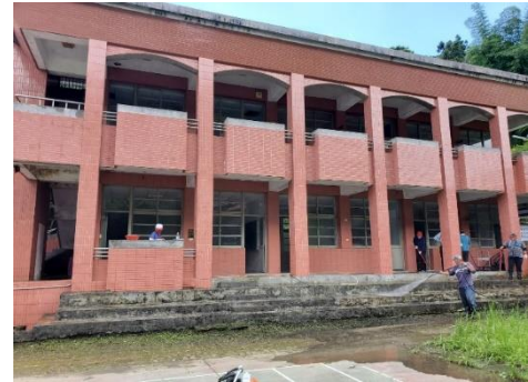
建物外牆及路面青苔清洗
