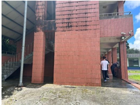
建物外牆及路面青苔清洗
