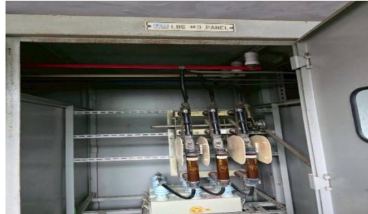
說明：森林館變電站高壓電纜頭更換
