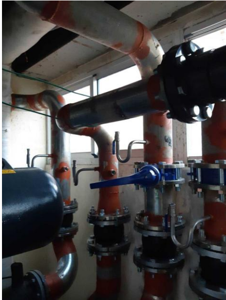
說明：活動中心 120RT 螺旋式冰水主機更新 及配管中
