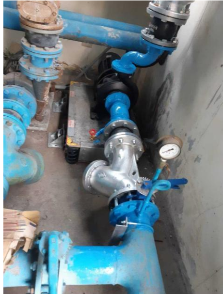
說明：活動中心 15HP 冷卻水泵更新
