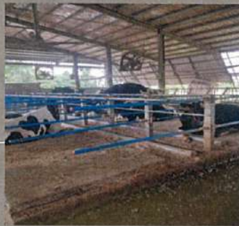
欄桿跟床墊換新
