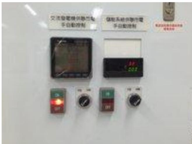
圖 99 系統教學平台之儲能系統併聯市電電表及開關位置
