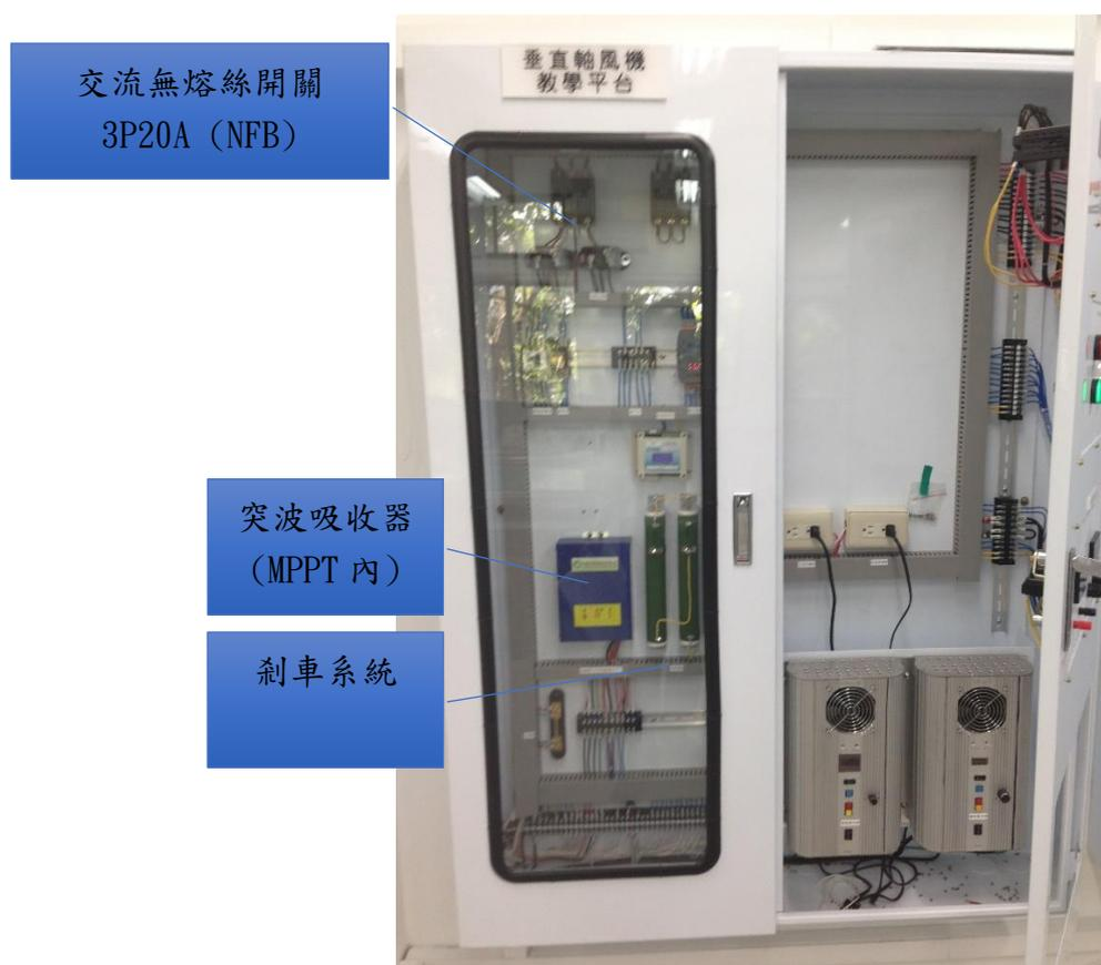
圖 72 風力發電機系統的接線相內部設備與配線
