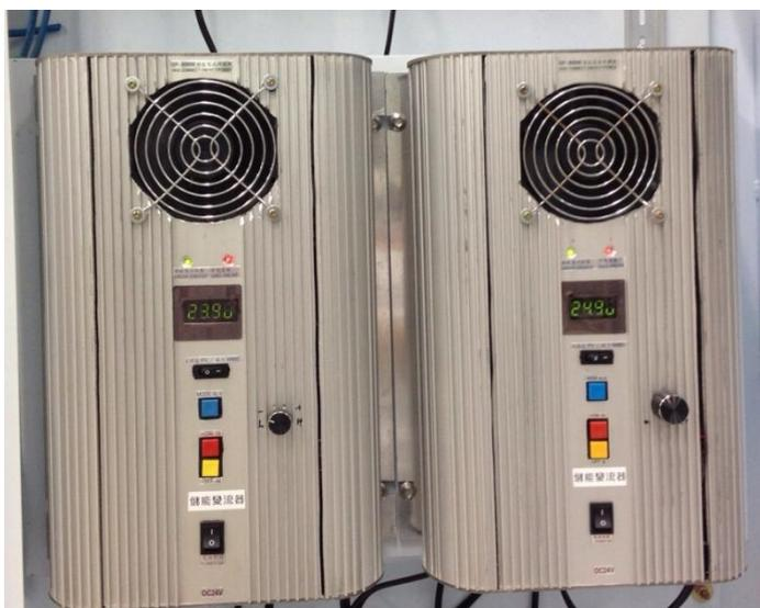
圖 7 直交流電力轉換器(逆變器)
