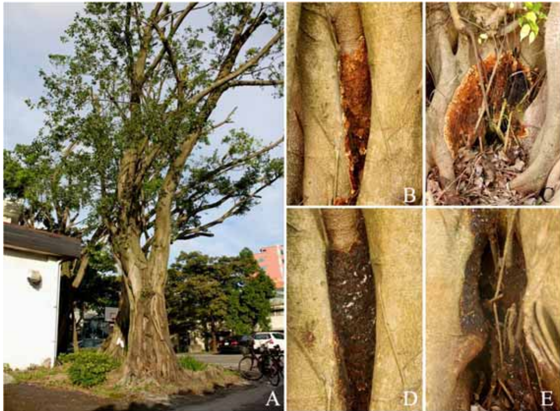
圖七、海洋工程所左側之兩棵垂榕已罹受褐根病，仍枝葉扶蘇；但其莖基部有菌絲組織(B、C)，已以瓦斯火焰噴槍燒灼 碳化處理(D-E)。
