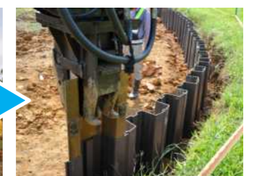
抽取鋼板導樁
