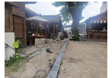
▲ 水溝組裝完成
