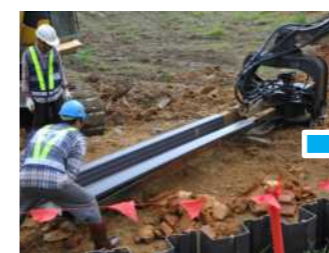
安裝塑鋼板樁
