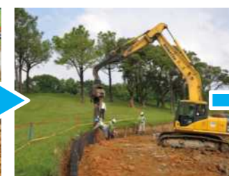
打入塑鋼板樁
