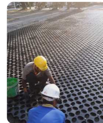
鋪設模具完成
