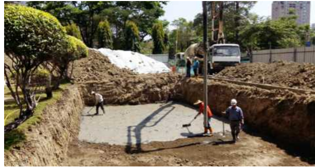
基地開挖打底
