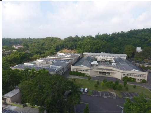
機電館、食品加工廠及水工材料試驗場
