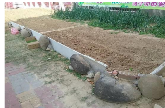
照片 15_水泥板構築圍砌~崇文國小。
