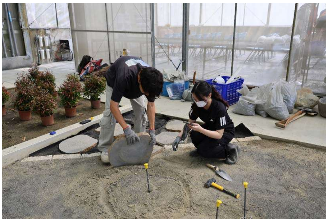
圖 2：學生進行石材鋪面實作，從定位到鋪設細節操作，培養精準施工與美感判斷能力。
