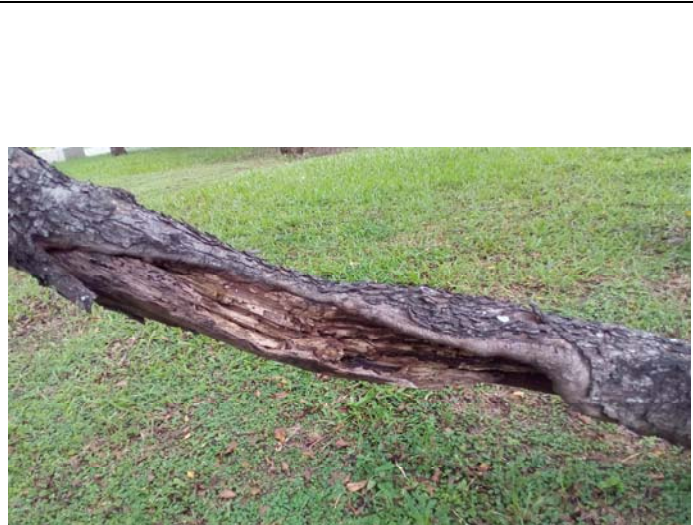
照片六：樹木腐朽
