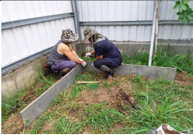
照片13：水泥板構築圍牆菜園。
