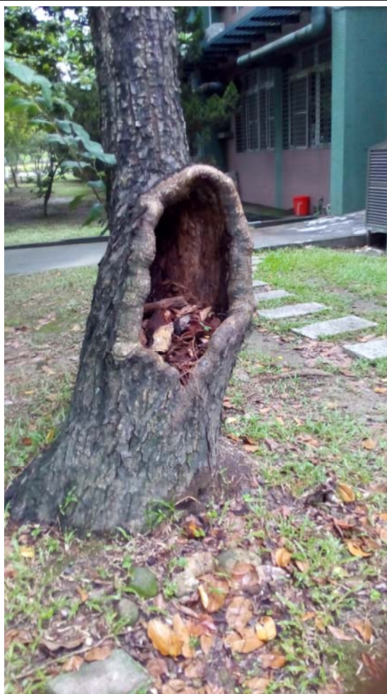
照片七：腐朽造成之樹洞
