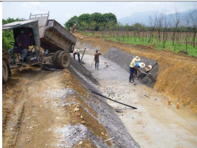
照片16：引水渠道施工。
